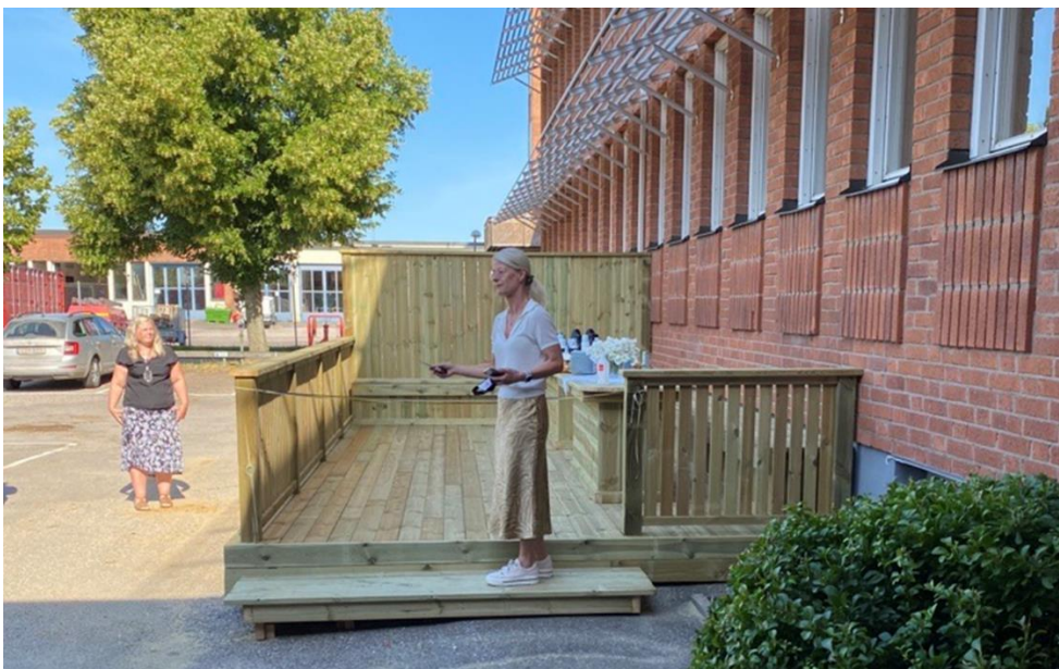
Bild tagen från sommaren 2021 när dåvarande Förbundschef Åsa Öberg Thorstensson tillsammans med medarbetare invigde den nybyggda altanen.
